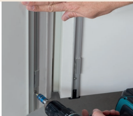
* 1. Bauphase - nur Befestigungsschienen montiert
